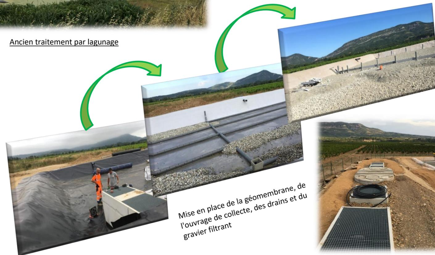
Mise en place de la géomembrane, de l'ouvrage de collecte, des drains et du gravier filtrant
