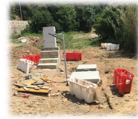
↑ Poste de relevage
