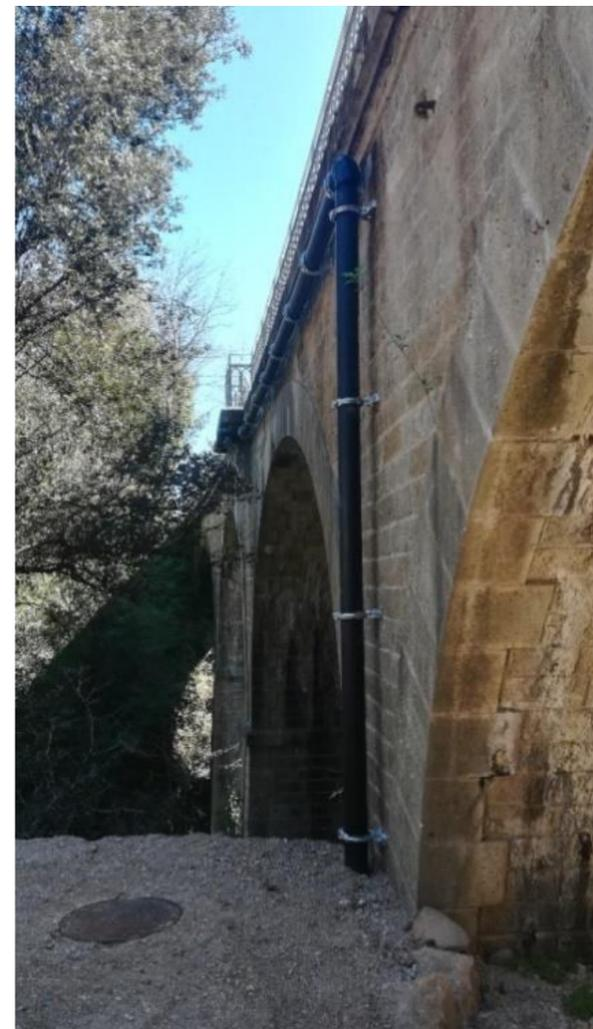
Encorbellement en canalisation PEHD Pré-isolée et collier de fixation en Aluminium AS 13
