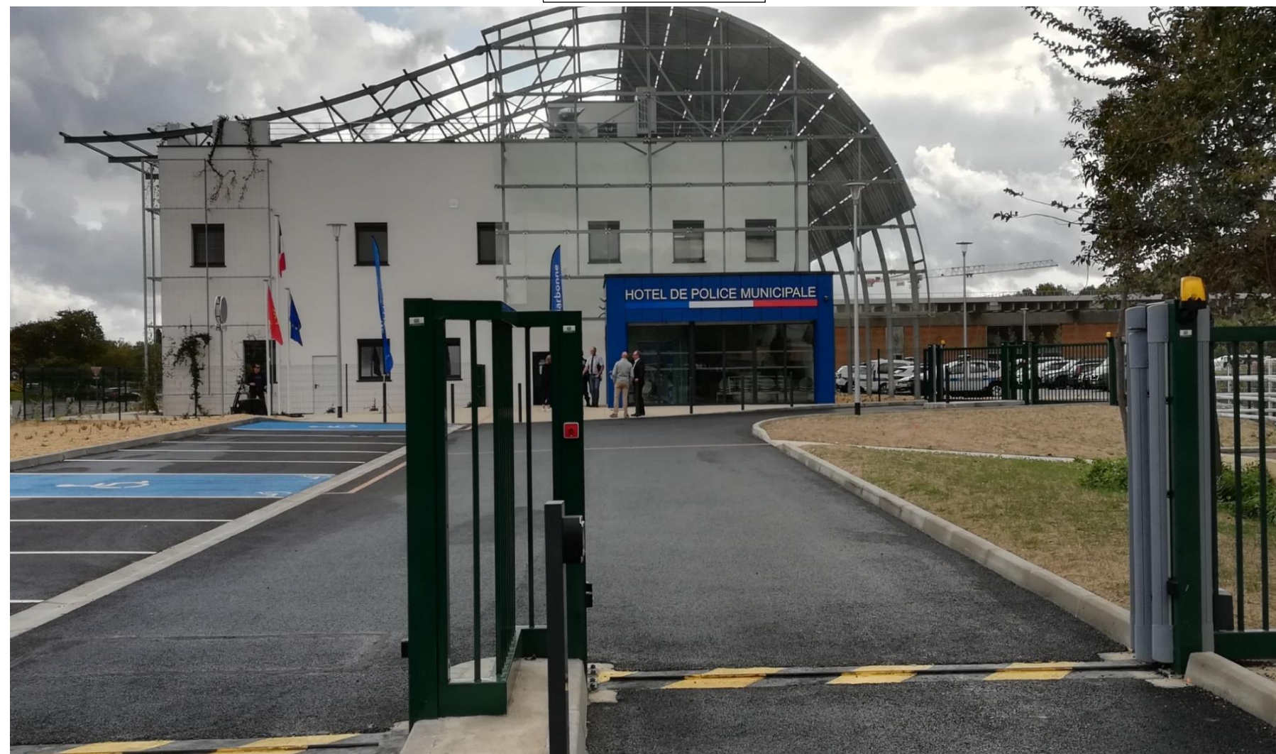
Photos Après Travaux
