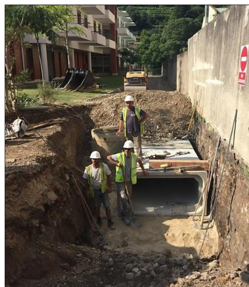
Secteur Hôpital pendant les travaux
