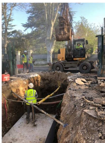
Secteur Stade pendant les travaux
