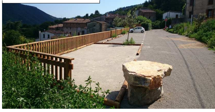
Photos Après travaux
