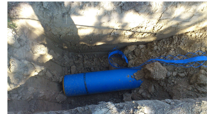
Renouvellement du réseau AEP
