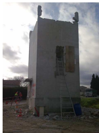
Photos Pendant Travaux
