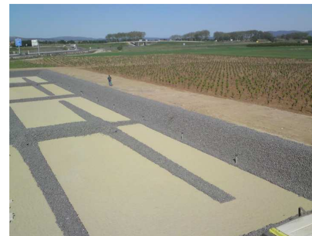
Nouvelle Station d'Epuration
