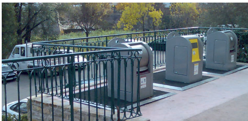
SICTOM DE LA HAUTE VALLEE DE L'ORB Bédarieux Mise en place de conteneurs enterrés
