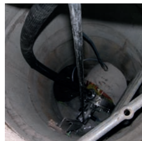
■ Ria Syrach Réhabilitation sans tranchée du réseau d'assainissement
