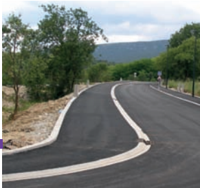
■ Cazilhac Aménagement lotissement communal
