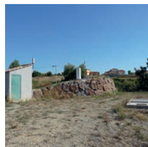
■ Puisserguier Création d'un poste de relevage des eaux usées
