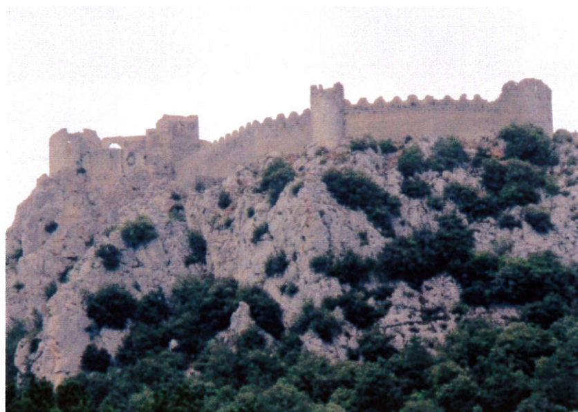
Photos Avant Travaux
